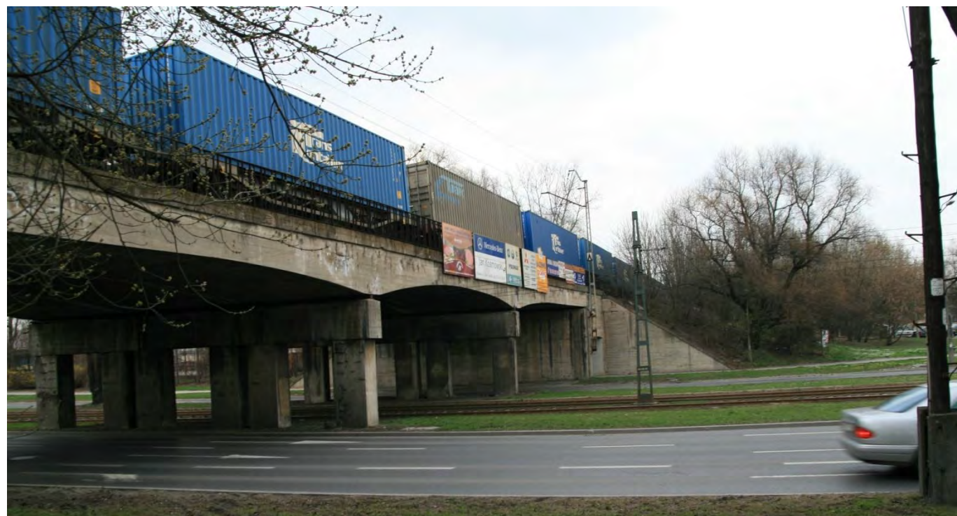
Rys. 137. Wiadukt kolejowy nad Aleją Pokoju – miejsce lokalizacji przystanku Szybkiej Kolei Aglomeracyjnej fot. Janusz Jeżak
