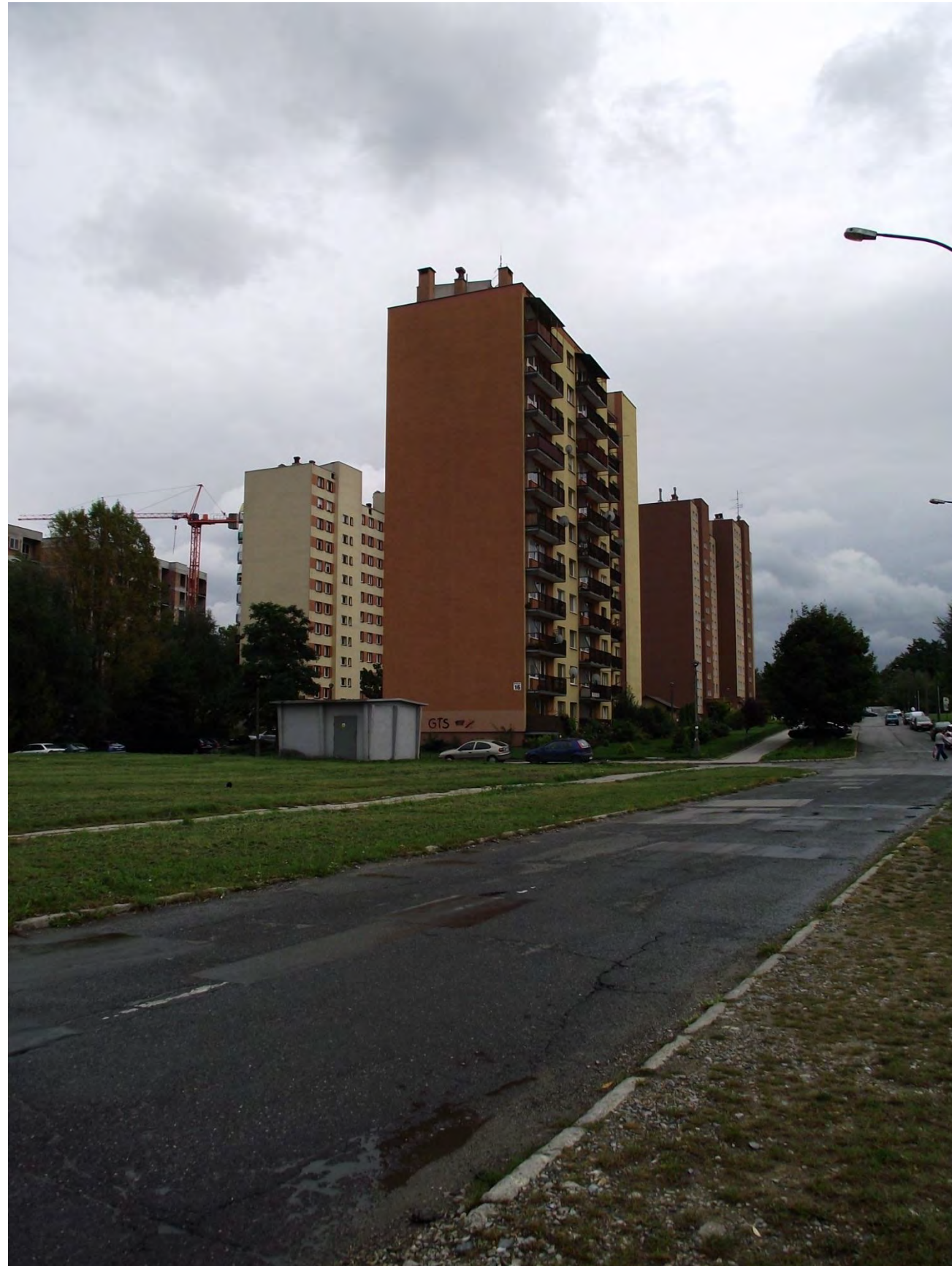
Rys. 361. Wysoka zabudowa w pobliżu zajezdni MPK przy ulicy Walerego Sławka fot. Marcin Nejman
