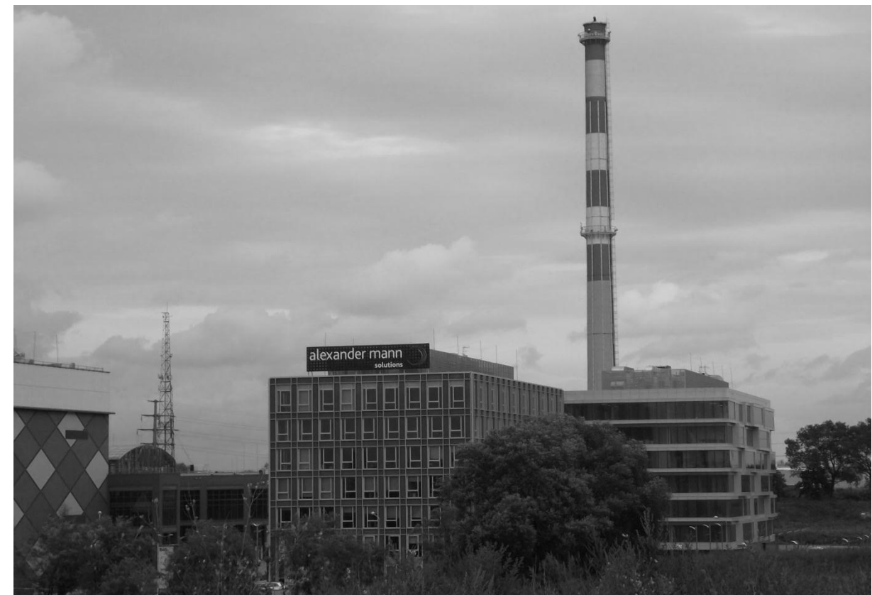
Rys. 339. CH Bonarka, na terenach po zespole Cementowni Bernarda Libana „Bonarka” – zachowany komin fot: Janusz Jeżak
