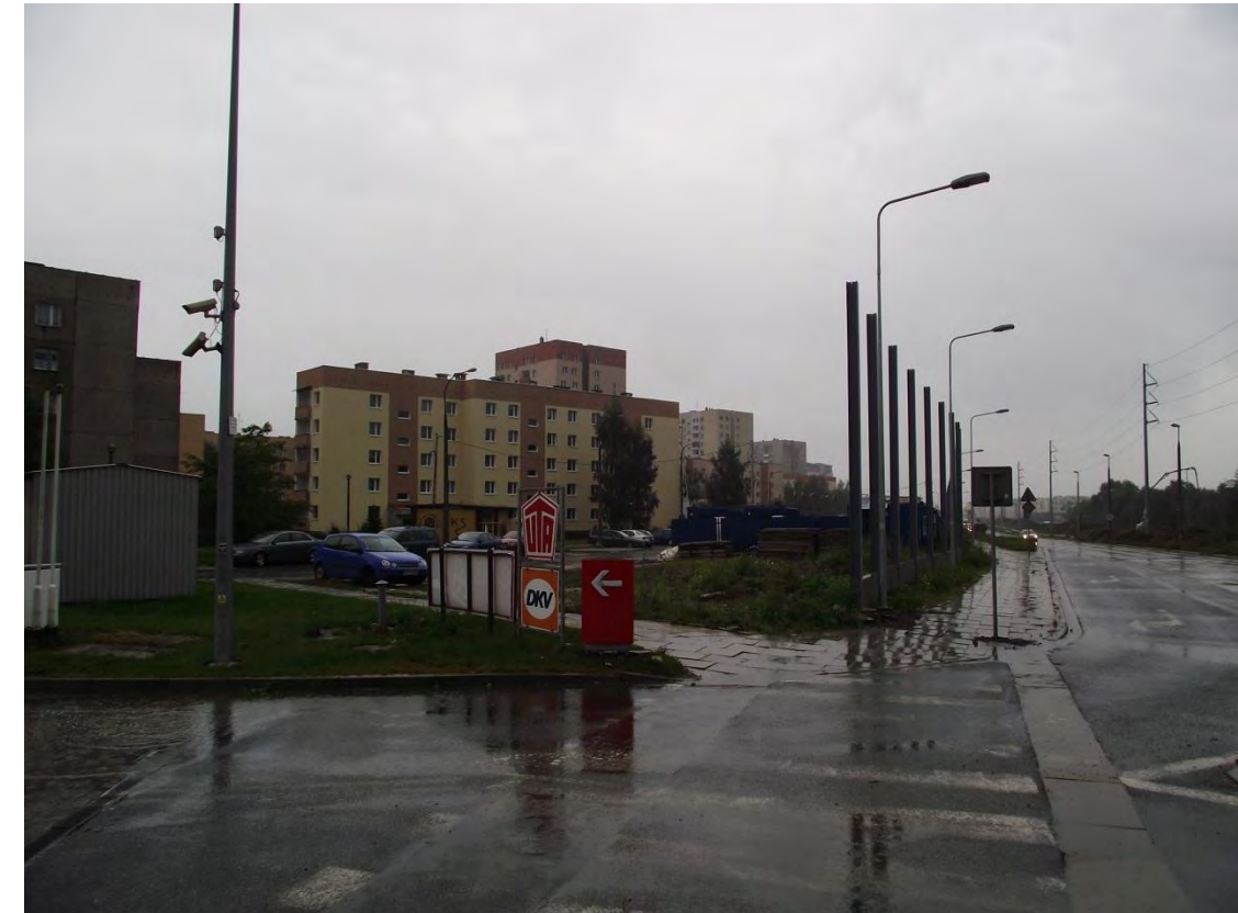
Rys. 332. Budowa ekranów akustycznych przy ulicy Grota-Roweckiego fot. Marcin Nejman
