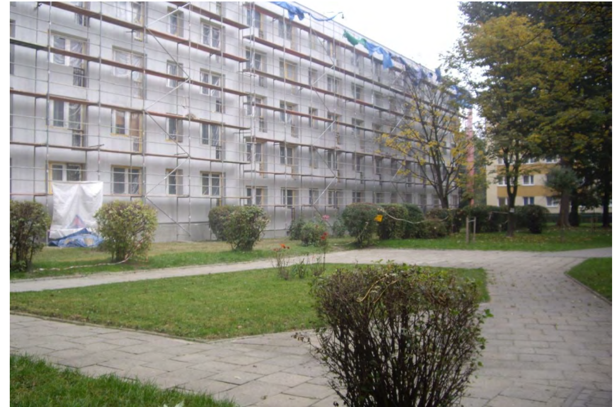
Rys. 43. Końcowy etap termomodernizacji budynku przy ulicy Czerwieńskiego 10 fot. Marcin Nejman
