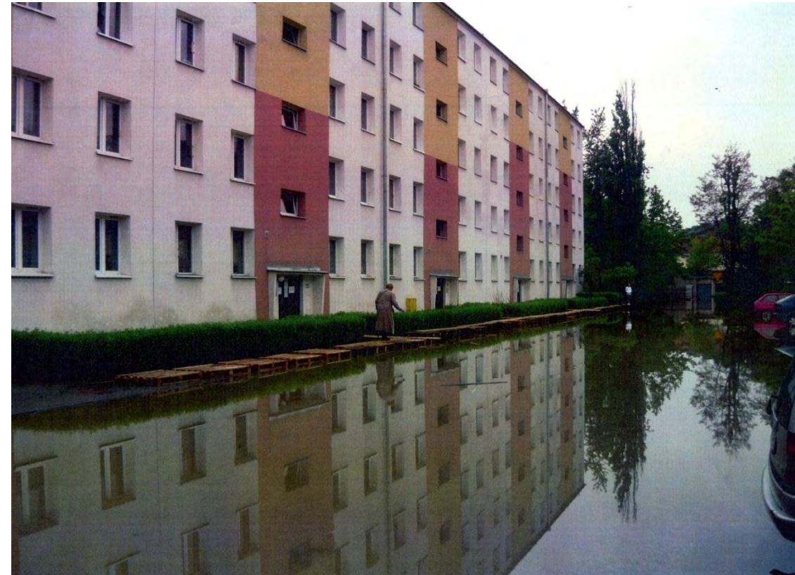
Rys. 406. Zalany obszar między blokami osiedla Podwawelskiego w maju 2010 roku fot. Spółdzielnia Mieszkaniowa „Podwawelska”
