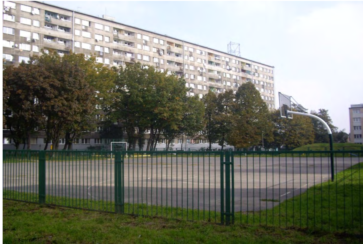
Rys. 41. Boisko przy ulicy Weissa fot. Marcin Nejman
