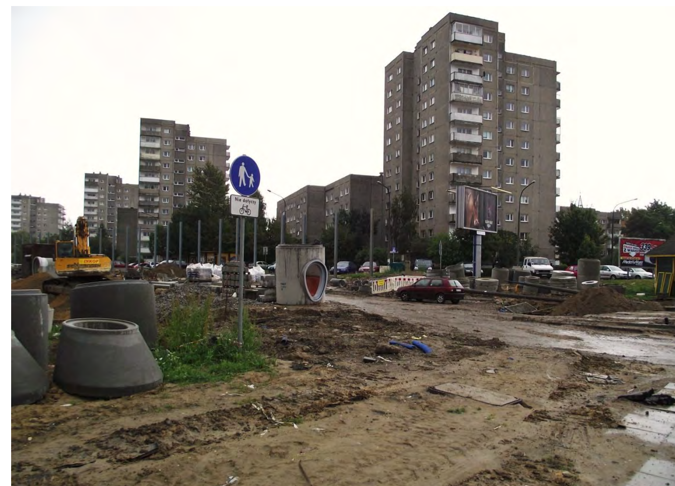
Rys. 318. Przebudowa ulicy Grota-Roweckiego, w tle zabudowa osiedla Ruczaj-Zaborze fot. Marcin Nejman
