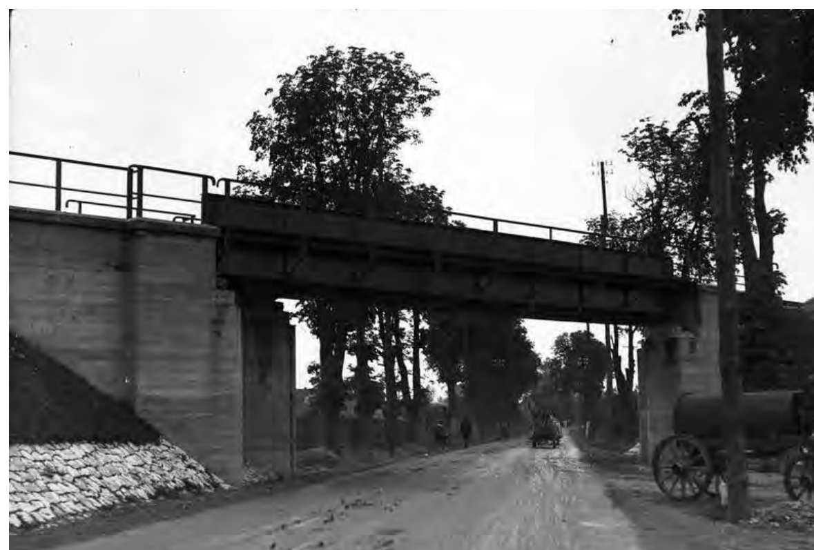
Rys. 47. Wiadukt nad szosą warszawską – 1934 rok fot: Ze zbiorów Narodowego Archiwum Cyfrowego
