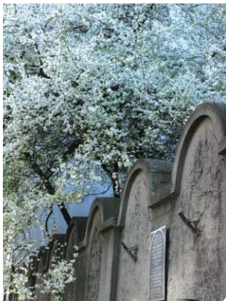
fot. 7 Mury Getta przy ul. Lwowskiej
