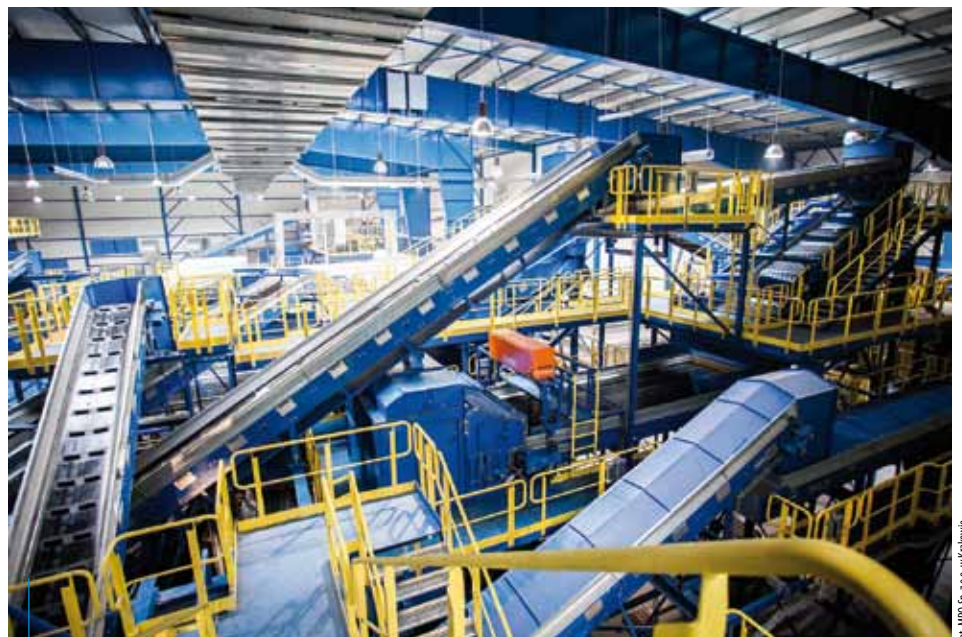
22 maja do użytku została oddana nowa sortownia odpadów, najnowocześniejszy tego typu obiekt w Polsce
