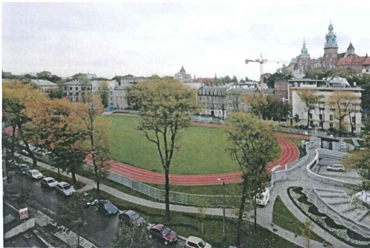
Nawierzchnia tuż przed otwarciem:
