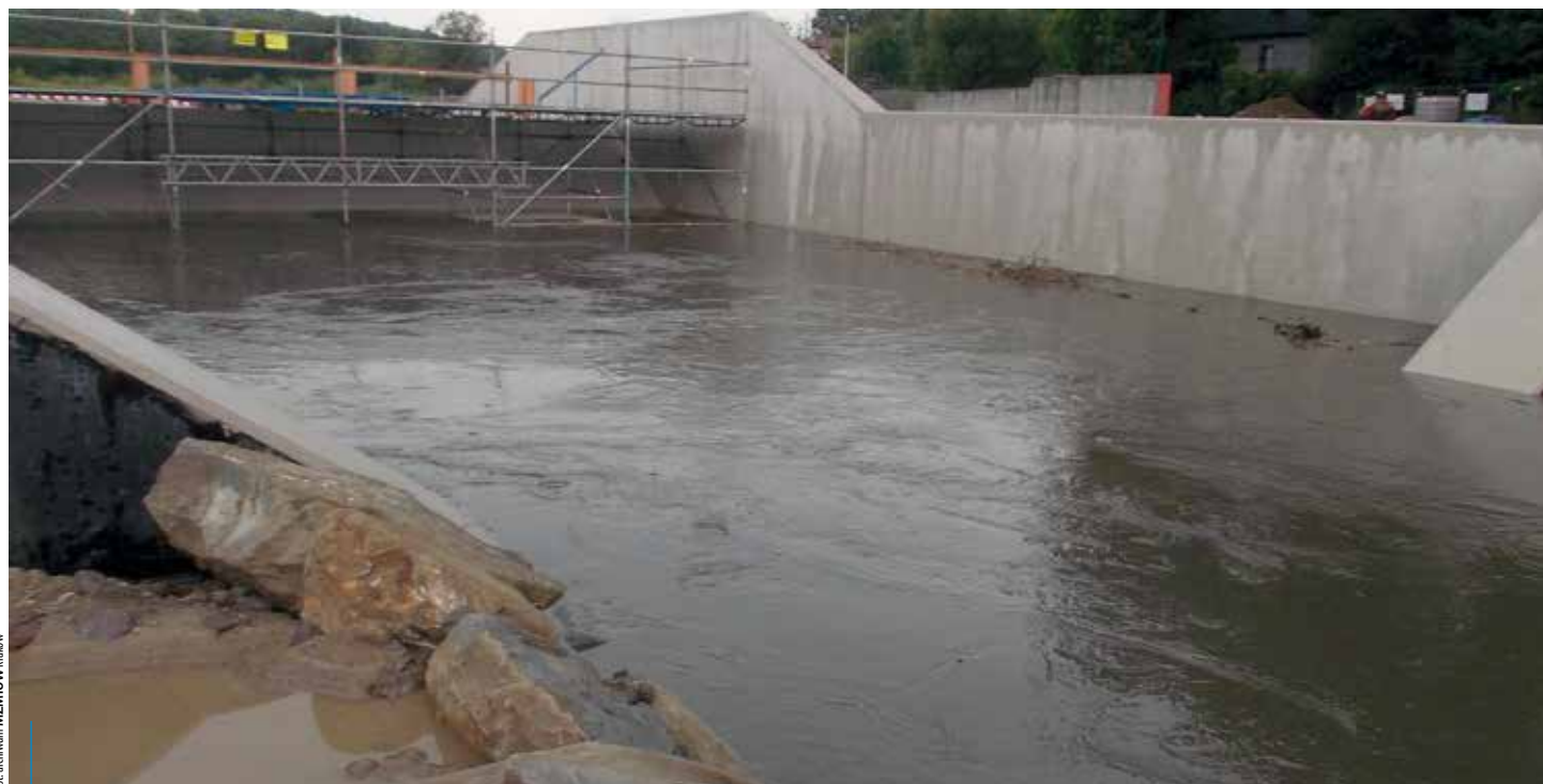
Po sierpniowej ulewie wezbrane wody Serafy przelały się do suchego zbiornika, co skutecznie zapobiegło zalaniu położonych poniżej terenów
