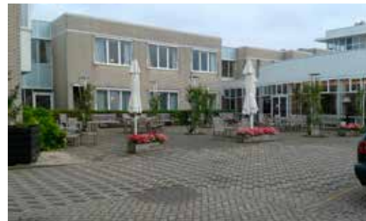
Ośrodek dziennego pobytu Careyn Snavenburg w Maarssen – widok z zewnątrz
