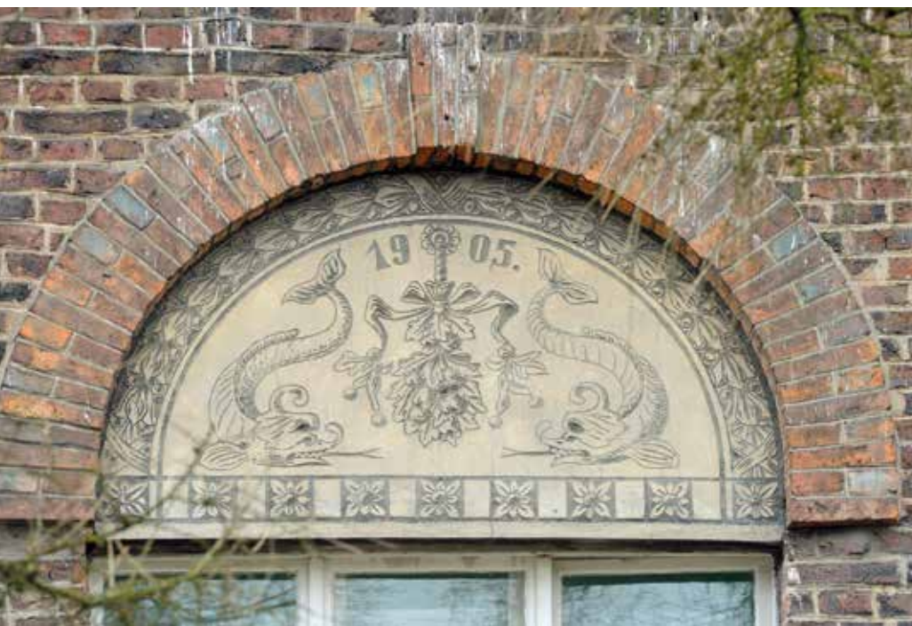
Elewacja kamienicy przy ul. Emaus 30 (dawniej 145)
