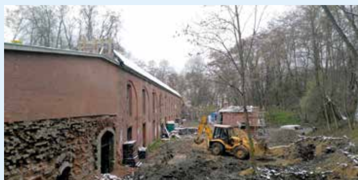
Trwa rewitalizacja fortu Borek na Klinach
