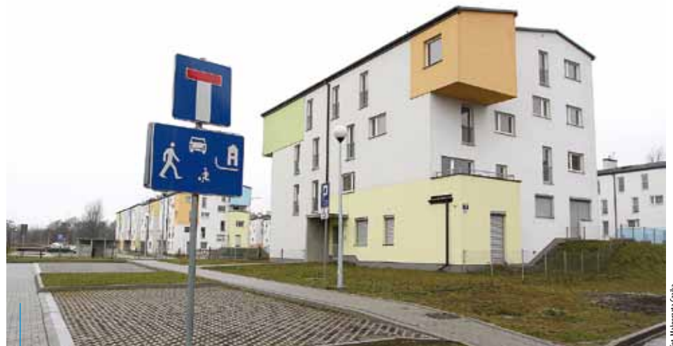
Osiedle komunalne przy ul. Magnolii powstało w 2008 r.
