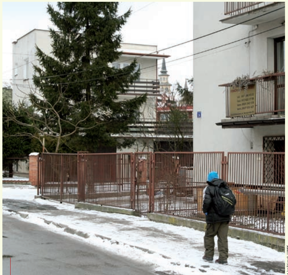
Ul. Narciarska w Czyżynach – remonty pilnie potrzebne.
