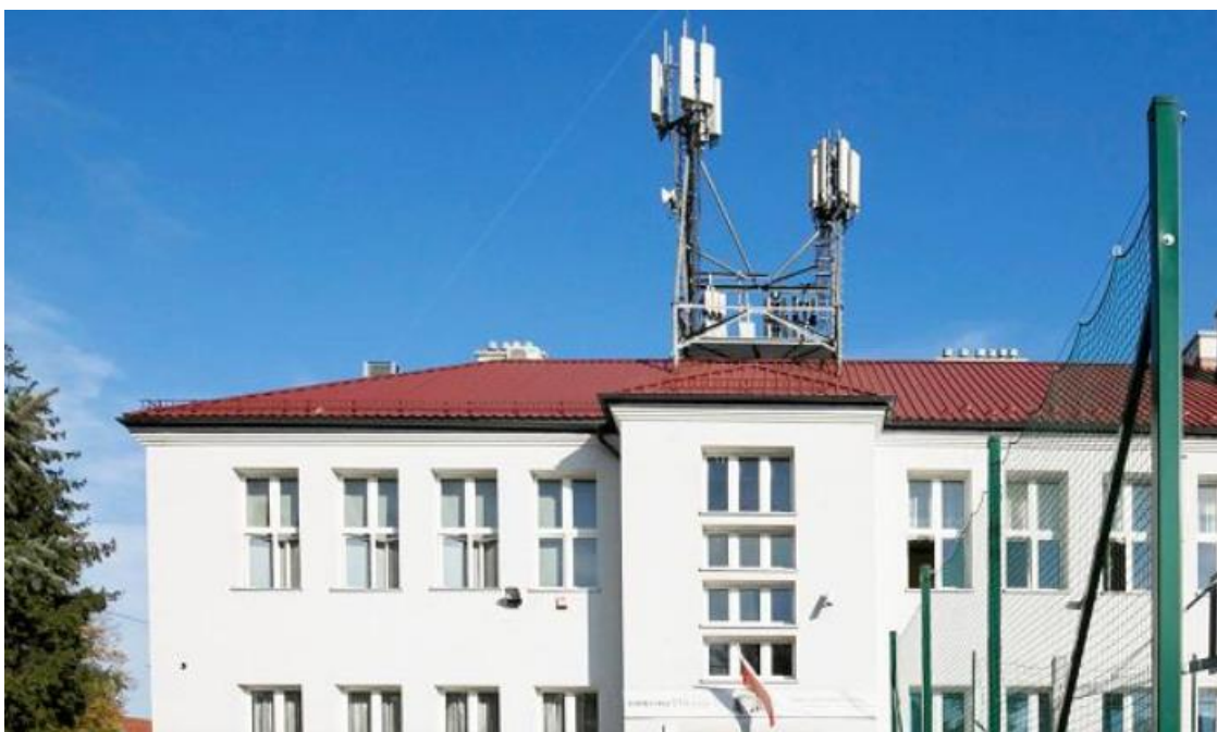
Rysunek 3. Stacje bazowe na dachu szkoły, Kraków, ul. Myślenicka 112
