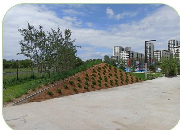
Ekranu typu „zielona ściana” oraz bariera akustyczna w postaci wału ziemnego.
