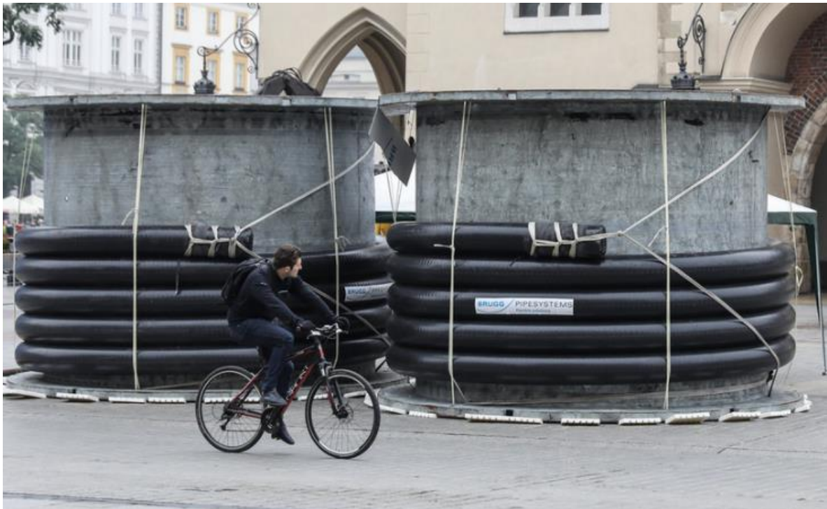
Innowacyjne działania: elastyczne ciepłociągi przeznaczone do stosowania w trudnych, nietypowych lokalizacjach (MPEC)
