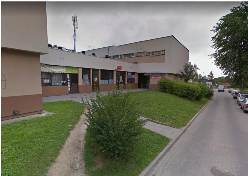
Rysunek 3. Stacje bazowe na dachu budynku - Kraków, ul. Teligi 24
