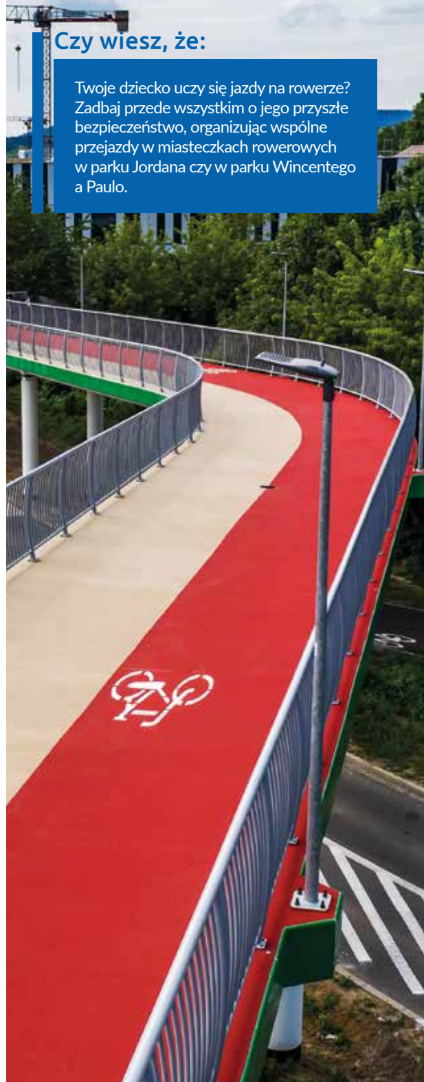
Kładka pieszo-rowerowa wzdłuż ul. Kamieńskiego w Krakowie, fot. Bogusław Świerczowski
