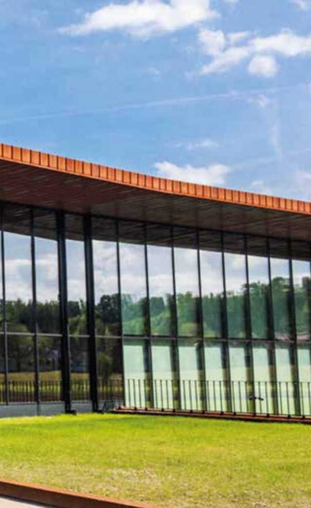
Hala 100-lecia KS Cracovia wraz z Centrum Sportu Osób Niepełnosprawnych, fot. Mateusz Chwajot
