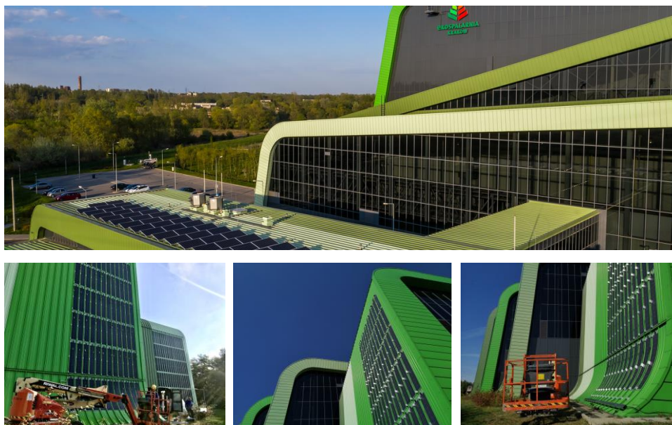
Figure 9 Elastyczne i lekkie panele fotowoltaiczne na dachu Ekospalarni – program pilotażowy dla budynków gminnych
