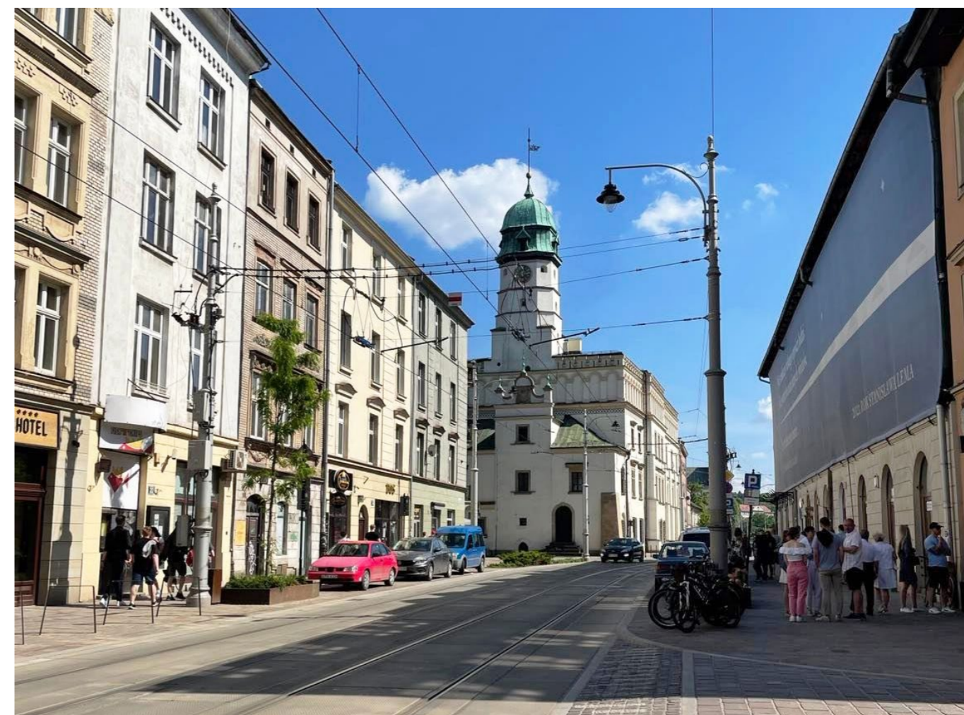
Fot. 23. Widok na ul. Krakowską w kierunku południowym ze skrzyżowania z ul. Skąpczą. Rekomendowanym działaniem dla tej ulicy jest zachowanie charakteru handlowo-usługowego.
