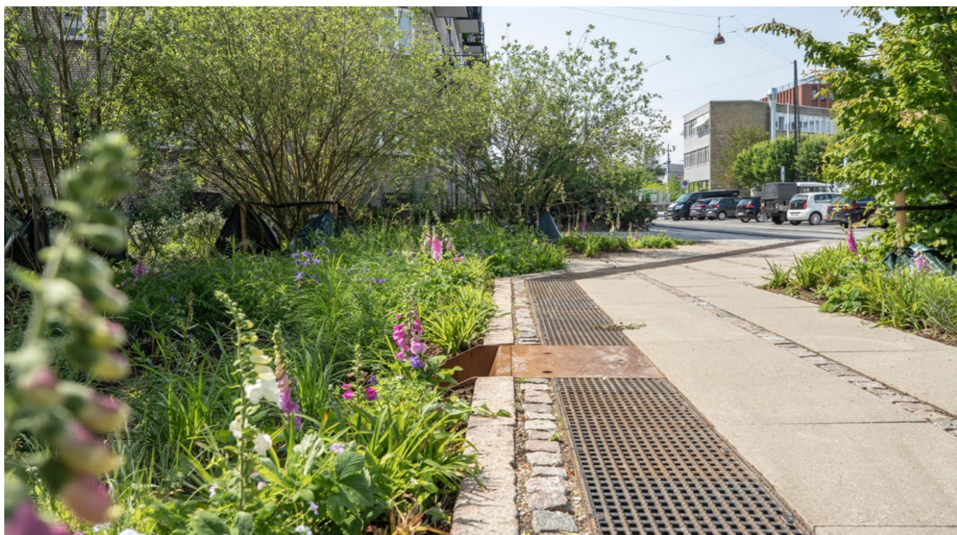
Fot. 26. Widok na elementy infrastruktury odprowadzającej wodę do ogrodu deszczowego Źródło: landezine-award.com/sankt-kjelds-square-and-bryggervangen/
