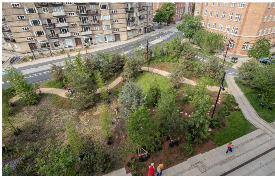
Fot. 29. Charakter wprowadzanej zieleni powinien uwzględniać przebieg podziemnej infrastruktury technicznej
