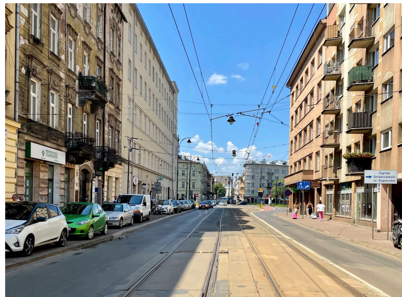
Fot. 24. Widok na ul. Starowiślną w kierunku Starego Miasta. Rekomendowanymi działaniami dla tej przestrzeni są m.in. wprowadzenie zieleni wysokiej oraz zielonego torowiska.
