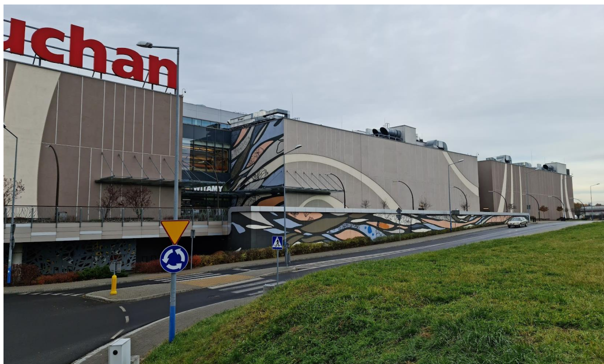
Galeria Bronowice - Urządzenia na dachu obiektu.
