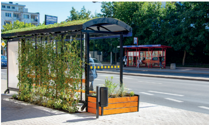
Zdjęcie 13: Przystanek z zielonym dachem i ścianą w Białymstoku 34
