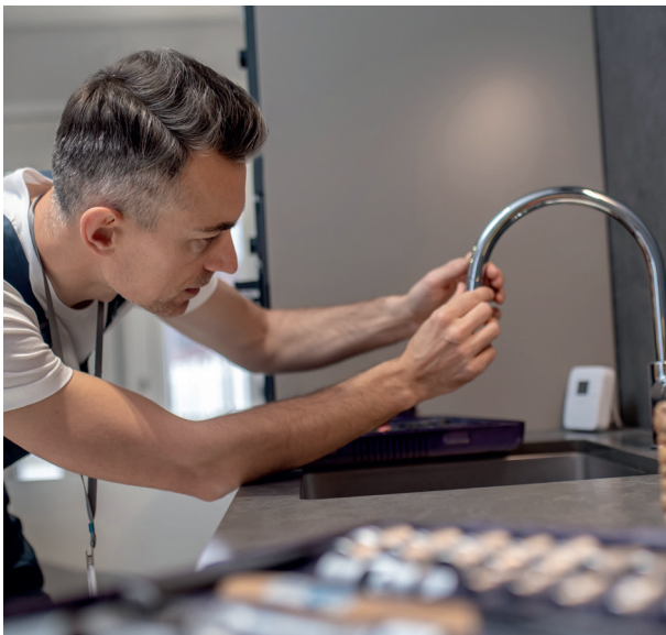
Zdjęcie 3: Montaż perlatora na baterii kranu
