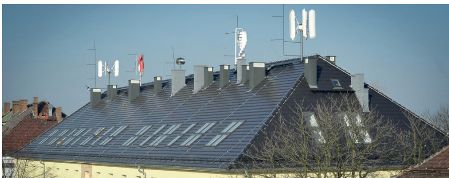
Zdjęcie 3: Turbiny pionowe na dachu budynku Instytutu Elektroenergetyki i Energii Odnawialnej – Politechnika Opolska
