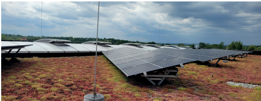
Zdjęcie 4: Dach biosolarny – połączenie zielonego dachu ekstensywnego z panelami fotowoltaicznymi 21
