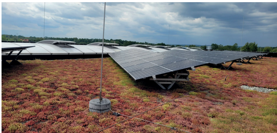
Zdjęcie 5: Dach biosolarny – połączenie zielonego dachu ekstensywnego z panelami fotowoltaicznymi 21
