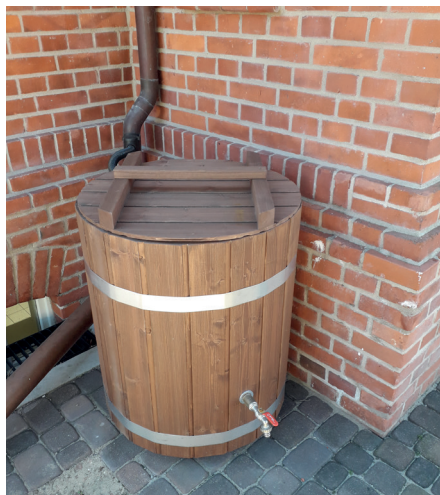
Zdjęcie 8: Zagospodarowanie wody deszczowej – powierzchnia przepuszczalna i beczka na deszczówkę
