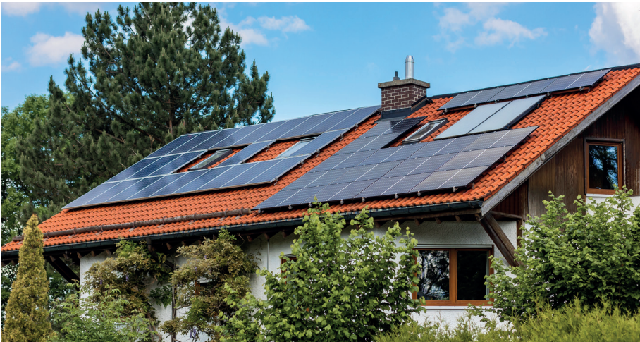
Zdjęcie 6: Panele fotowoltaiczne na dachu domu jednorodzinnego
