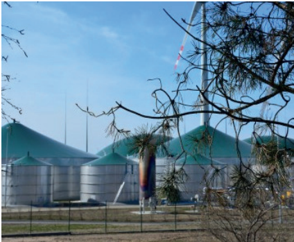
Zdjęcie 2: Elektrownia biogazowa w Darżynie (woj. pomorskie) 5
