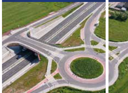
Rozbudowa ul. Igołomskiej
