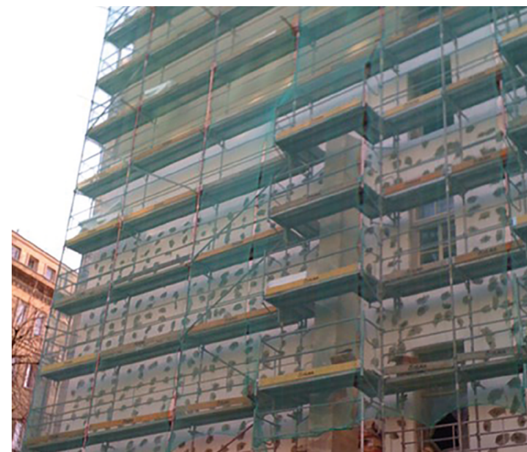
Rysunek 04-1 Ocieplenie budynku metodą lekką-mokłą (ETICS). Źródło: opracowanie własne.
