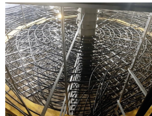
Rysunek 09-5 Wymiennik znajdujący się w magazynie energii. Źródło: opracowanie własne.
