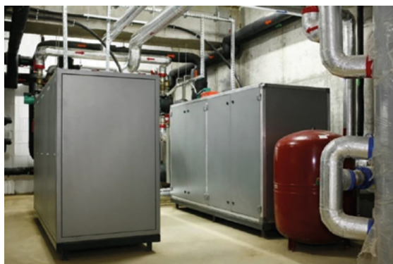
Rysunek 09-4 Hybrydowa maszynownia z kaskadowymi, gruntowymi pompami ciepła. Źródło: opracowanie własne.
