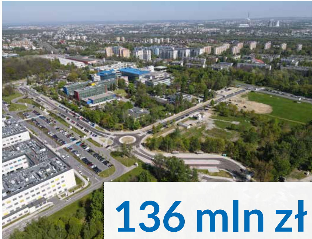
Rok 2023 przyniósł zakończenie prac przy modernizacji dróg dojazdowych do Szpitala Uniwersyteckiego.
