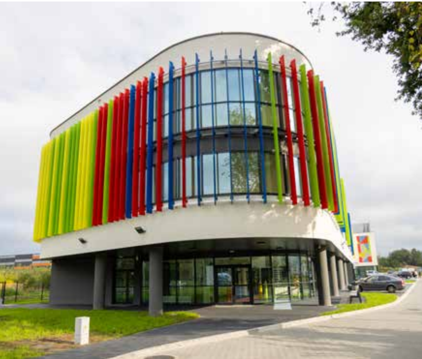
Nową szkołę podstawową na Złocieniu wyróżnia nie tylko kolorowa elewacja, ale także boisko na dachu.
