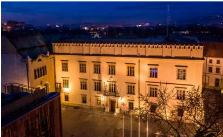
Reprezentacyjny budynek przy pl. Wszystkich Świętych 3–4, tradycyjnie nazywany pałacem Wielopolskich, od 1864 r. jest siedzibą władz miasta Krakowa.
