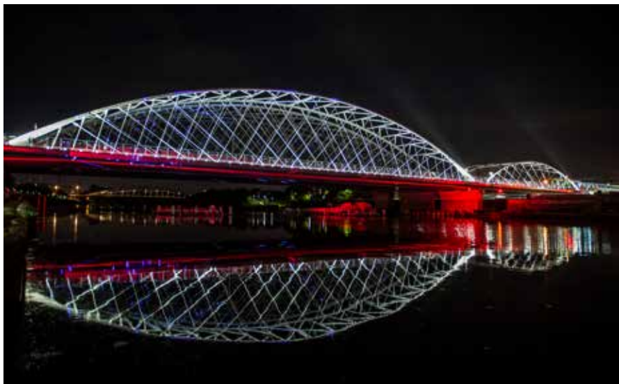
Piesi i rowerzyści mogą korzystać z nowej przeprawy przez Wisłę. Kładka, która towarzyszy wyremontowanej linii kolejowej, łączy Zabłocie z Grzegórkami i Kazimierzem.
