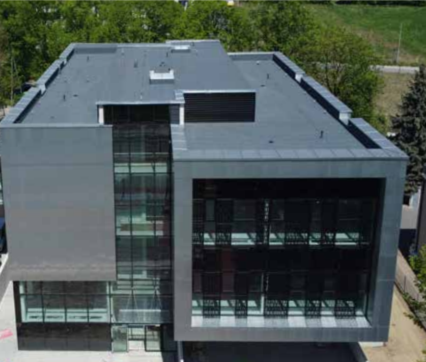
Dzięki rozbudowie Szkoły Podstawowej nr 50 przy ul. Katowickiej obiekt zyskał m.in. 8 sal lekcyjnych i 3 świetlice.
