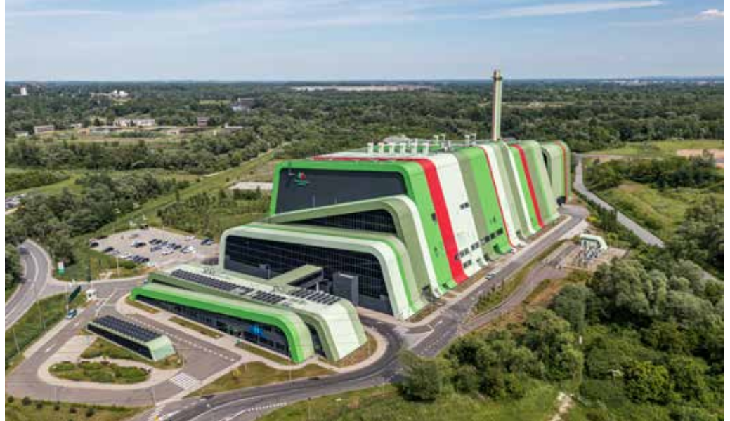
Zakład Termicznego Przekształcania Odpadów w Krakowie (Ekospalarnia) to jedno z najbardziej nowoczesnych tego typu przedsiębiorstw w Europie.
