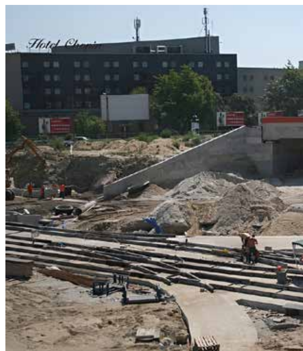
Budowa ronda Mogińskiego, lipiec 2007 r.
