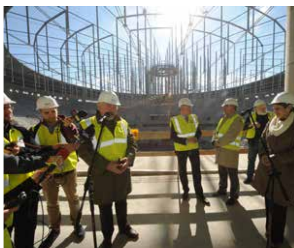
Wizytacja budowy hali w Czyżynach, wrzesień 2013 r.
