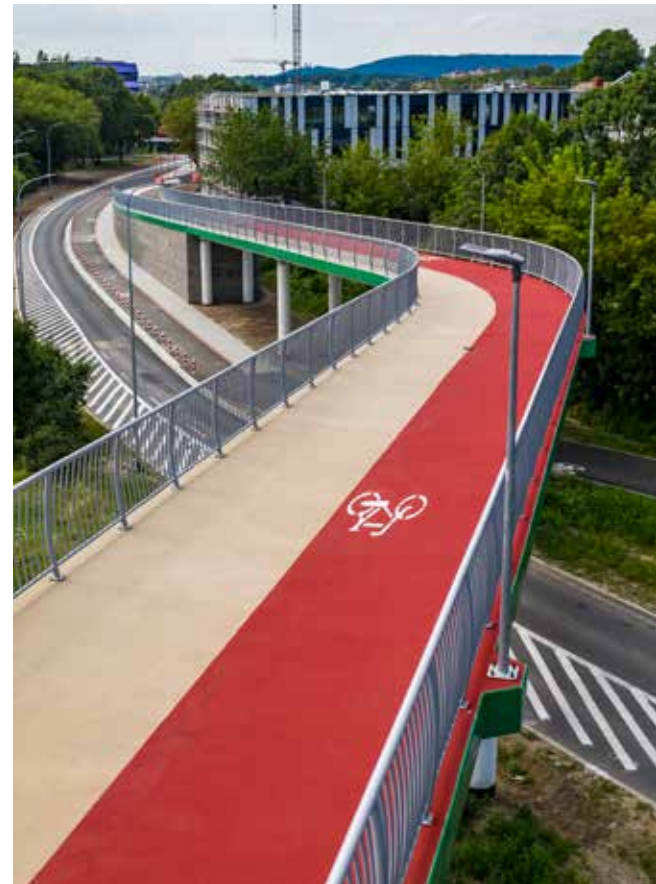
Kładka wzdłuż ul. Kamieńskiego pozwala na bezkolizyjne i komfortowe pokonanie przez pieszych i rowerzystów skrzyżowania ulic Kamieńskiego, Powstańców Śląskich oraz torów kolejowych.
