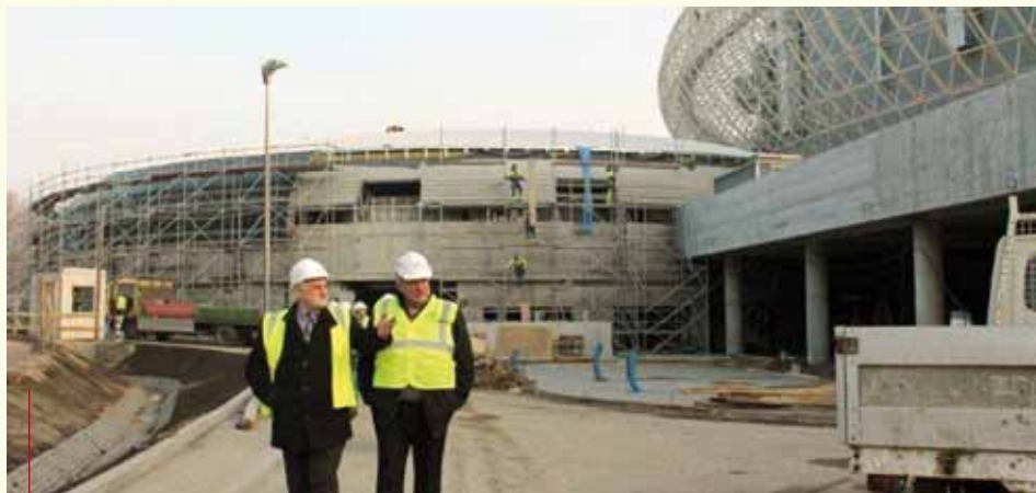
Prace przy Kraków Arena mają zakończyć się do 29 kwietnia
